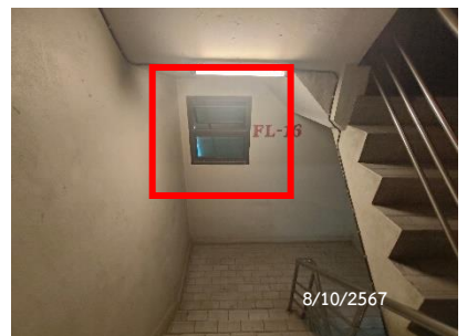
ช่องระบายอากาศบันไดหนีไฟ
