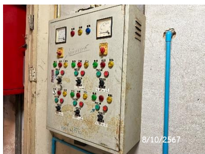
ตัวควบคุมระบบบำบัดน้ำเสีย
